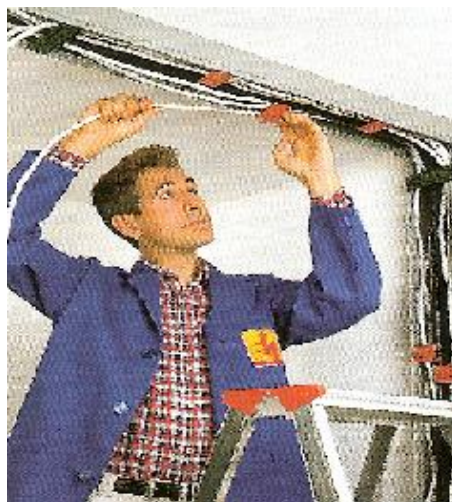
Obr. 1 - ukladanie vedenia do inštalačných žľabov
